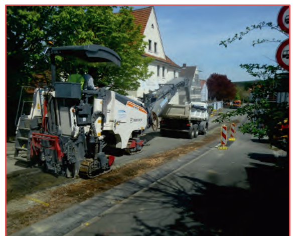
Sanierung der Ortsdurchfahrt Heinersreuth „Cottenbacher Straße“ (BT 14)
